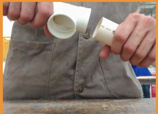
4. para isso, encaixe os "T"s entre os canos de 30cm. Pressione bem; se necessário, use cola de PVC
