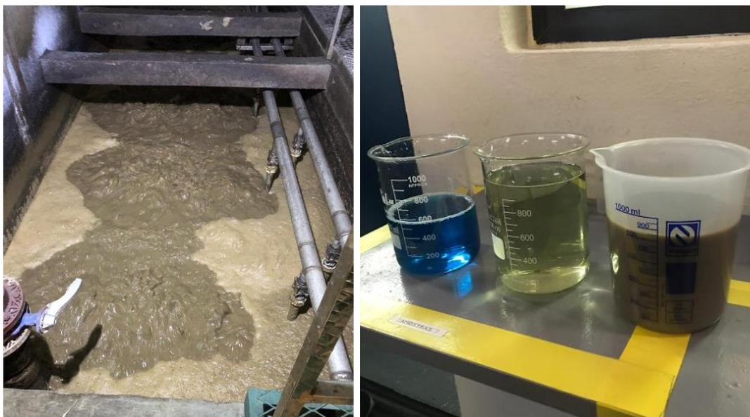
Figura 2. Tanque de aerção ETE Shopping JK Figura 3. Água resultante do tratamento por MBR.
