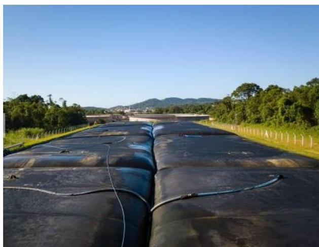
Figura 4: Exemplificação de tratamento de lodo por Geossintéticos.
